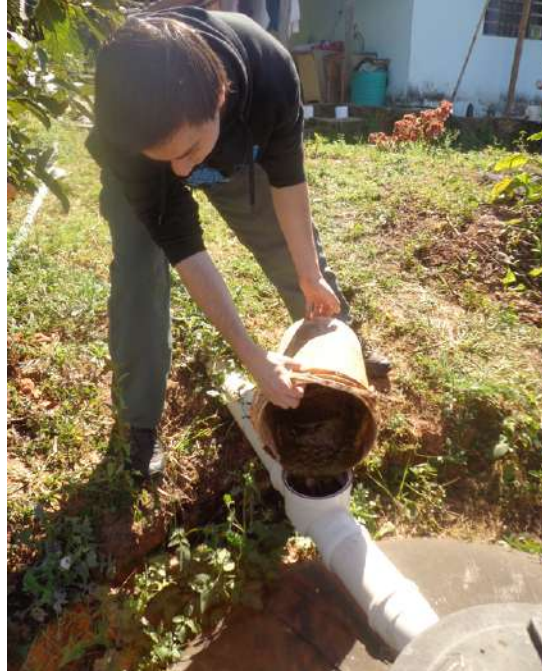
FIGURA 3. Adição mensal de esterco bovino fresco, na válvula de retenção, antes da primeira caixa. Campinas-SP (Foto: Isabel Figueiredo).
