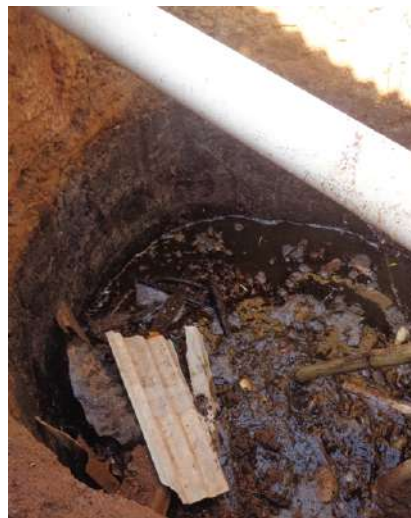
FIGURA 20A. Exemplo de fossa absorvente ou rudimentar. Interior de uma fossa construída com anéis de concreto (o fundo não é impermeabilizado) (Foto: Isabel Figueiredo).
