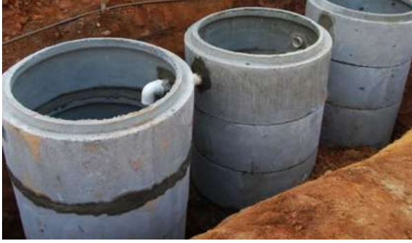
FIGURA 2. RAC sendo construído com anéis de concreto (zimbras). É possível observar a impermeabilização entre os anéis, na parte interna (Foto: Isabel Figueiredo).
