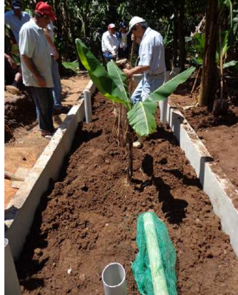
FIGURA 4. Preenchimento da camada de terra e plantio das bananeiras. Abaixo é possível ver o “ladrão” de tubo PVC perfurado e envolto por tela de mosquito (Foto: Luana Cruz).
