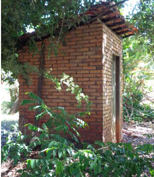
FIGURA 2. “Casinha” sem uso, construída em alvenaria. Propriedade rural de Campinas-SP (Foto: Isabel Figueiredo).
