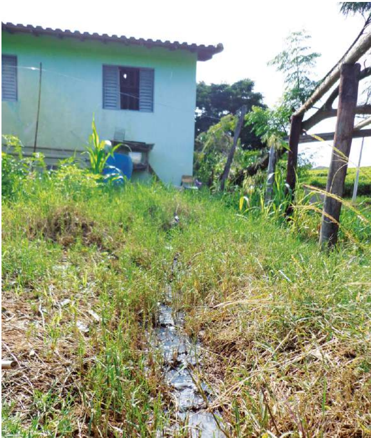
FIGURA 7. Lançamento de esgoto in natura diretamente no solo em propriedade rural (Foto: Isabel Figueiredo).
