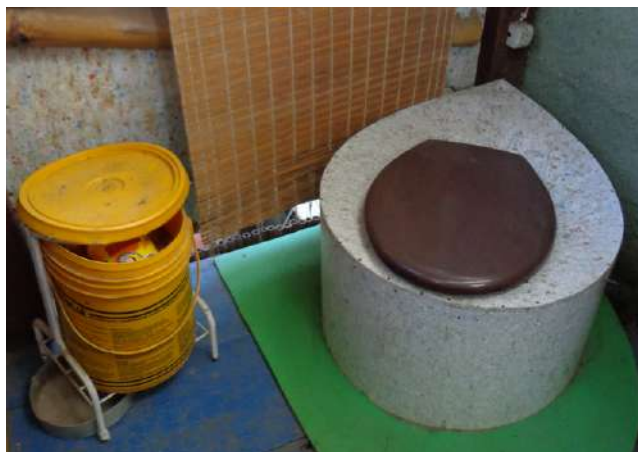
FIGURA 3. Banheiro seco de balde na Casa dos Hólons em São Paulo, SP (Foto: Isabel Figueiredo).
