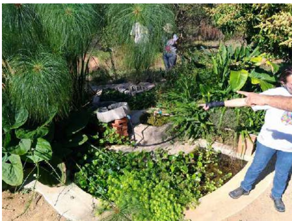
FIGURA 3. BSI unifamiliar no Espaço Almagestum, Pedra Bela-SP. O filtro anaeróbio e zona de raízes foram construídos sobre o biodigestor. No centro, o encanamento para saída do biogás (Projeto: Guilherme Castagna. Foto: Isaías Reis).
