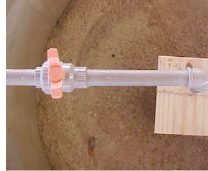
FIGURA 2. Filtro de areia construído em anéis de concreto para tratamento de esgoto vindo de um tanque séptico (Foto: Luana Cruz).
