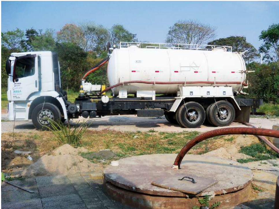
FIGURA 38A. Caminhão tipo limpa- fossa fazendo a limpeza do lodo em tanque séptico semicoletivo em Campinas/SP (Foto: Luana M. O Cruz).
