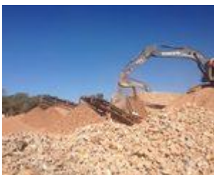
Usina de reciclagem de resíduos da construção
