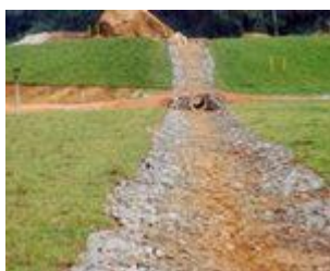
Drenagem superficial de aterro sanitário
