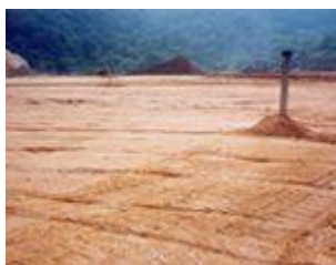
Platô de aterro sanitário e drenagem de gases
