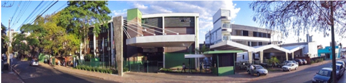
Figura 2. Fachada da Embrapa Instrumentação, em São Carlos/SP
