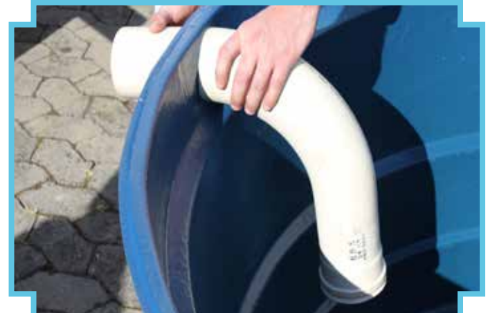
4 - Encaixe a curva no outro furo da caixa d'água
