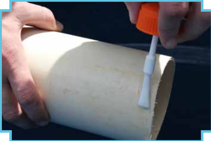
5 - Passe cola por dentro da curva de PVC e por fora do cano de 100 mm
