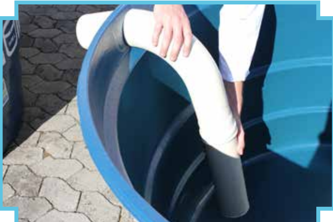
6 - Encaixe o cano de 100 mm de PVC no final da curva
