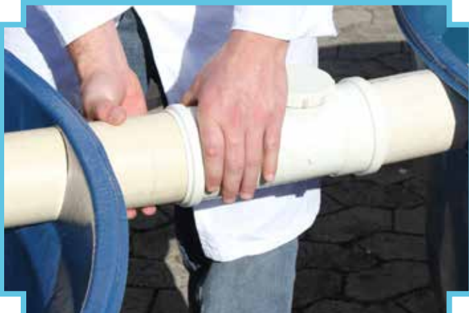
3 - Encaixe o cano no tê de inspeção da primeira caixa d'água
