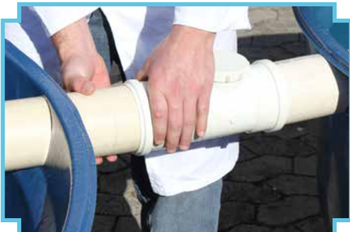
3 - Encaixe o cano no tê de inspeção da segunda caixa d'água
