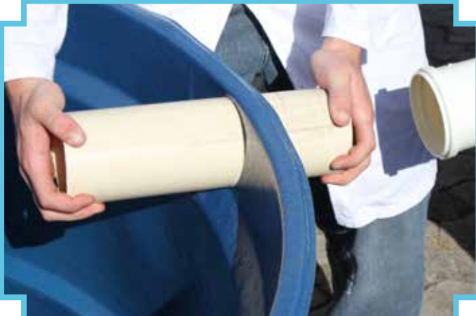
1 - Encaixe o cano de 100 mm de PVC na segunda caixa d'água
