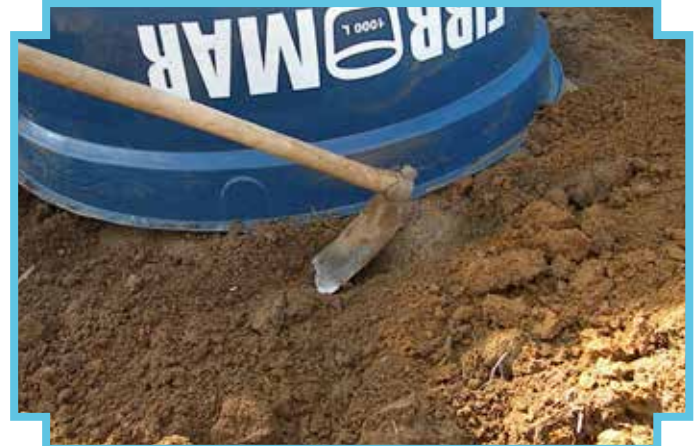
2 - Vire a caixa e marque o tamanho que o buraco deve ter (15 cm maior que o fundo da caixa)
