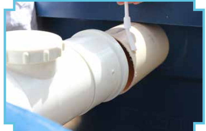
2 - Passe cola no cano de 100 mm de PVC
