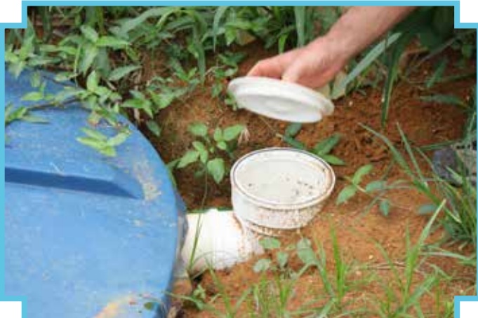
3 - Abra a tampa da válvula de retenção
