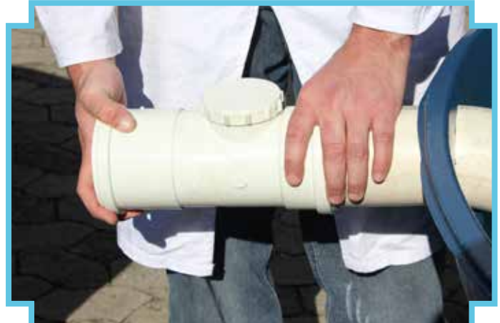
8 - Encaixe o tê de inspeção no final da curva da segunda caixa d'água
