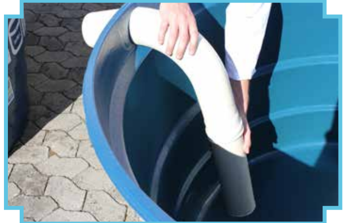
6 - Encaixe o cano de 100 mm de PVC no final da curva
