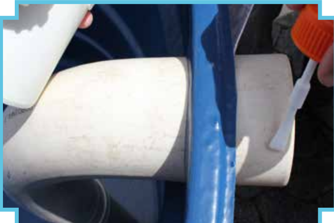
7 - Passe cola por fora da curva de PVC e por dentro do tê de inspeção
