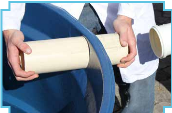
1 - Encaixe o cano de 100 mm de PVC na terceira caixa d'água
