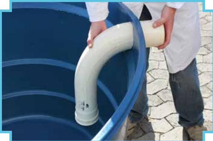
4 - Coloque a curva de PVC no furo esquerdo
