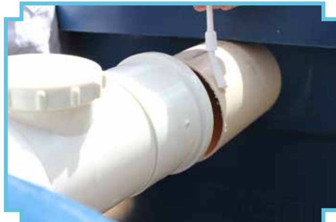
2 - Passe cola no cano de 100 mm de PVC
