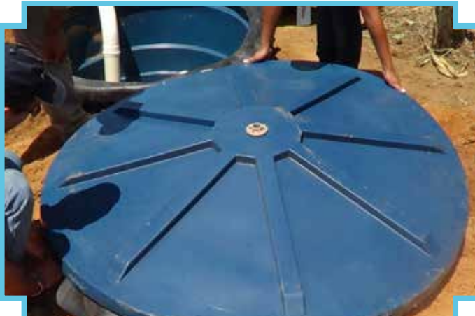
1 - Coloque a tampa sobre a caixa d'água
