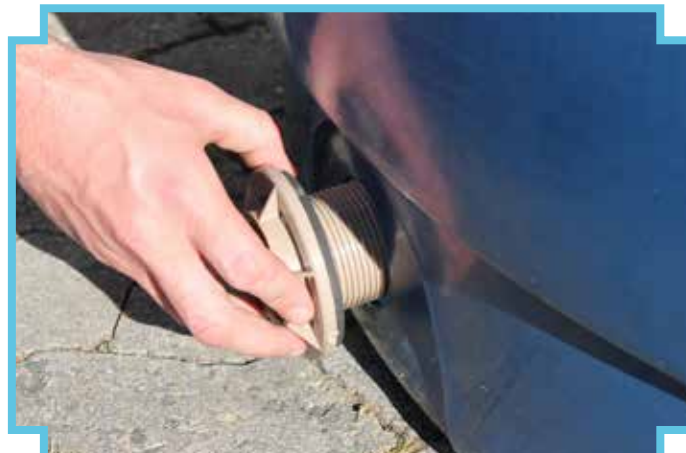
4 - Encaixe a flange de 50 mm no furo inferior da caixa d'água
