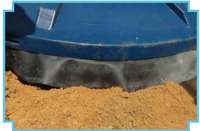
2 - Os furos da tampa devem coincidir com os furos da borda da caixa
