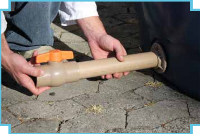
11 - Encaixe o registro de esfera na outra ponta do cano de 50 mm
