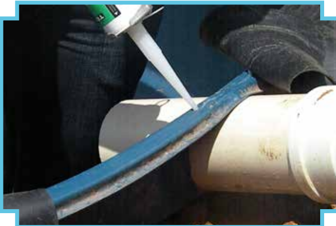
1 - Aplique silicone sobre a borda da caixa d'água
