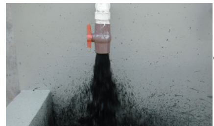
Fonte: ETE Mangueira, PE
