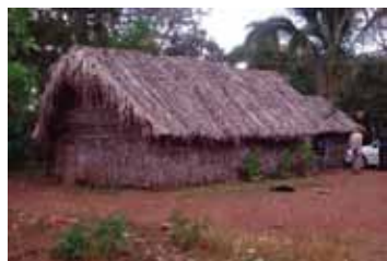
Figura 1 – Construção da escola, utilizando-se a palha de babaçu para cobertura e paredes. A palha é colhida durante a Lua cheia, para proteção e para não dar bicho na palha, no Quilombo Mata Cavalu/MT.
