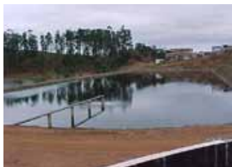
Lagoa de estabilização
