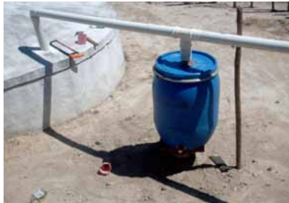
Figura 17 – Cisterna para água de chuva e dispositivo para descarte da primeira água.
