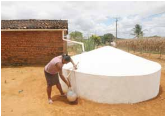
Figura 17 – Cisterna para água de chuva e dispositivo para descarte da primeira água.
