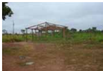
Figura 1 – Construção da escola, utilizando-se a palha de babaçu para cobertura e paredes. A palha é colhida durante a Lua cheia, para proteção e para não dar bicho na palha, no Quilombo Mata Cavalu/MT.
