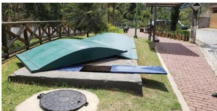
Foto 4. Vista da ETE com a caixa de gradeamento, uma tampa de acesso a um dos biodigestores aberta. Ao fundo, o parquinho sobre a caixa de areia e, depois, a zona de raízes com as plantas macrófitas.
