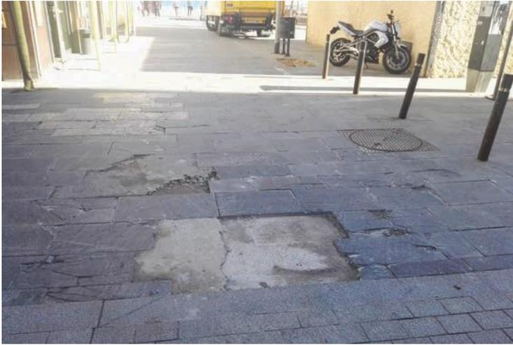
Foto 3. Rotura del pavimento debida al paso de vehículos pesados
