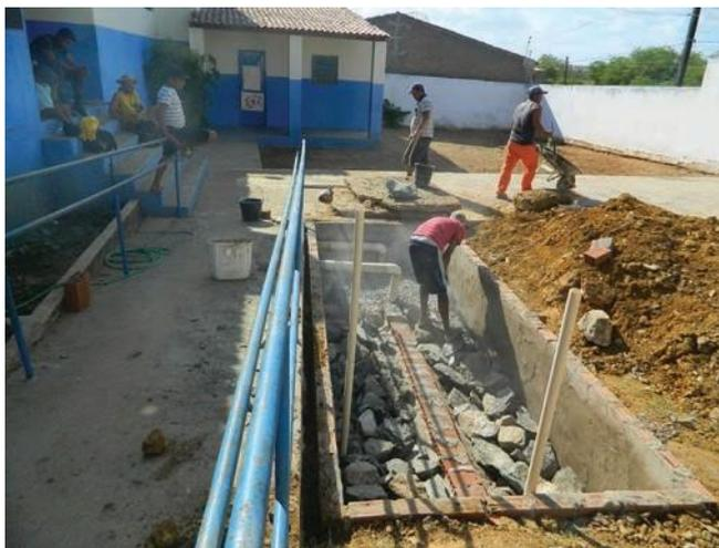
Foto 7. Sistema de tratamento de esgoto com câmara anaeróbica em cerâmica, na cidade de Batalha, Alagoas - Projeto Rondon, PUC-Rio
