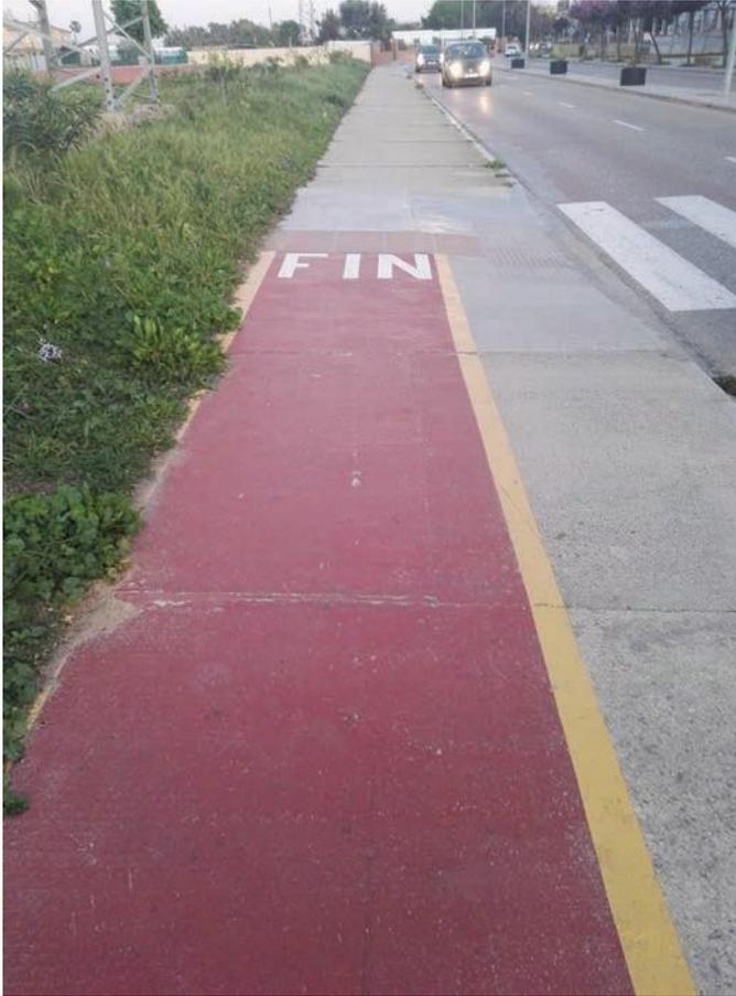
Foto 5. Separación inadecuada del carril para bicicletas
