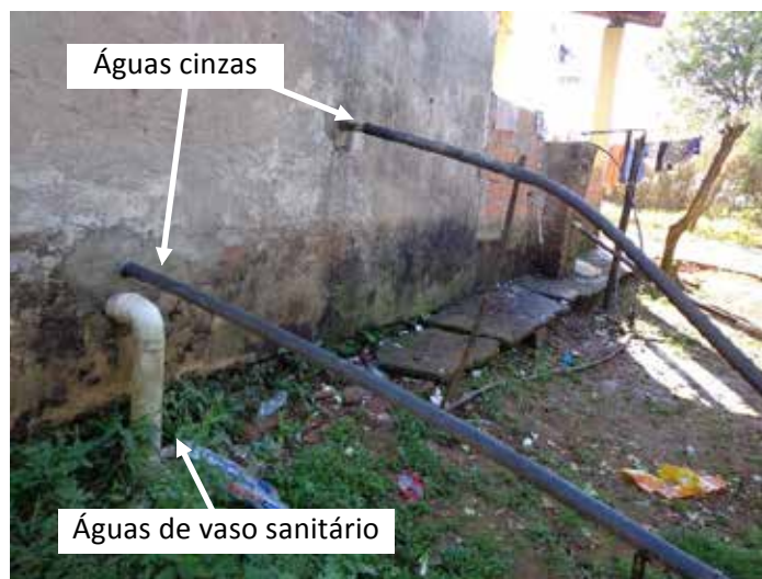
Figura 2 - Exemplos da segregação do esgoto em domicílios de uma comunidade rural de Campinas (SP).
