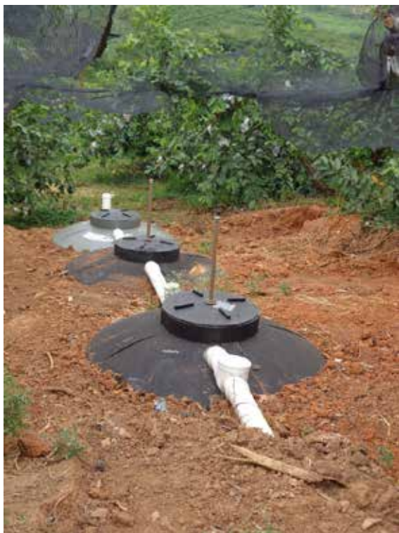
Figura 3 - Fossa Séptica Biodigestora construída na área rural de Campinas (SP). Esquerda - Visão geral do sistema. Direita - Registro localizado na base da terceira caixa, de onde era retirado o efluente para a irrigação. Fonte: Figueiredo (2019)
