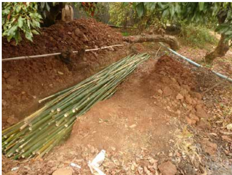
Figura 6 - Vala de infiltração preenchida com varas de bambu implantada em uma área rural de Campinas (SP).
