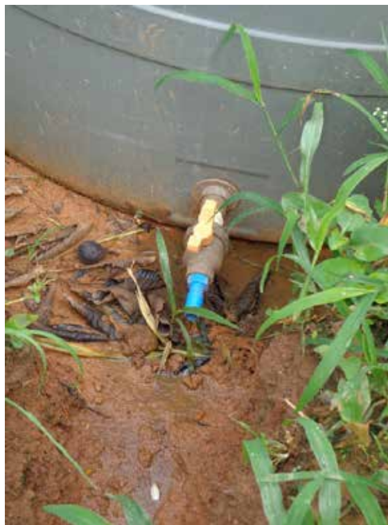
Figura 3 - Fossa Séptica Biodigestora construída na área rural de Campinas (SP). Esquerda - Visão geral do sistema. Direita - Registro localizado na base da terceira caixa, de onde era retirado o efluente para a irrigação. Fonte: Figueiredo (2019)
