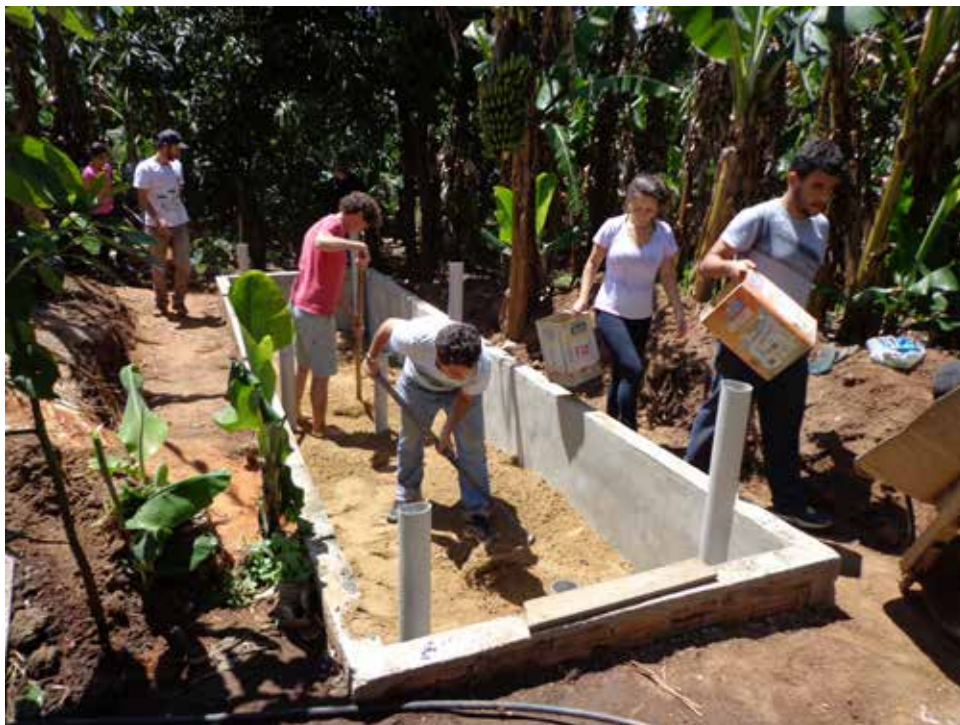
Figura 6 – Construção de Fossa Verde por sistema de mutirão
