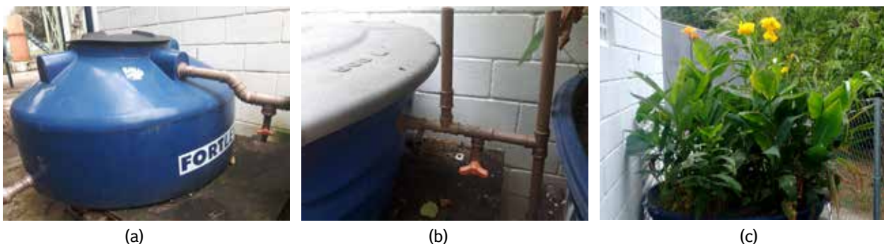
Figura 1 – Pontos de amostragem na saída da (a) fossa digestora (b) do decantador (c) do alagado construído
