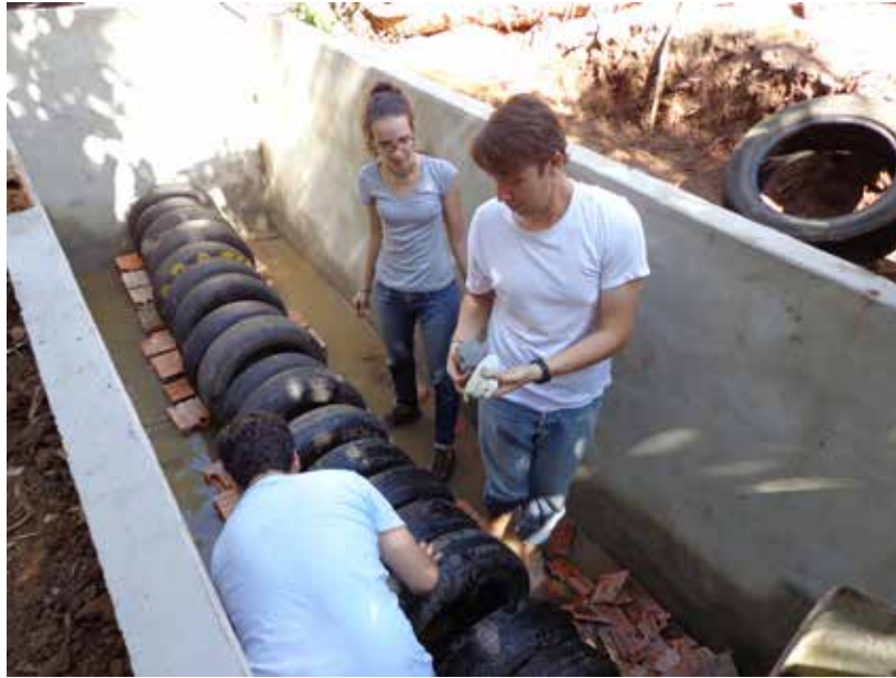
Figura 4 – Preenchimento da fossa verde com pneus para criação de uma câmara onde é distribuído o esgoto
