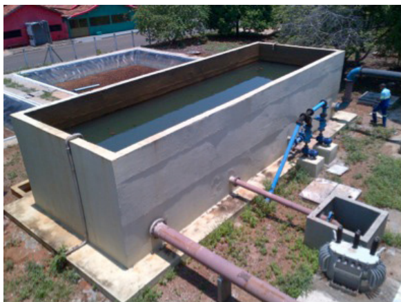
Figura 8 - Tanque de sedimentação e tubulações de água de lavagem e de recirculação
