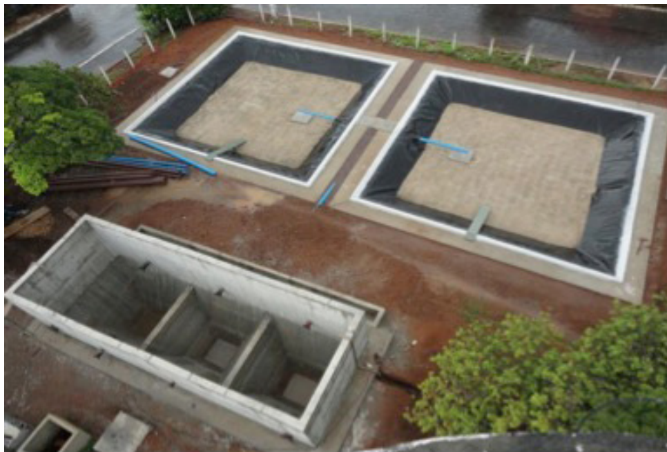
Figura 7 - Obra do tanque de decantação e leito de drenagem
