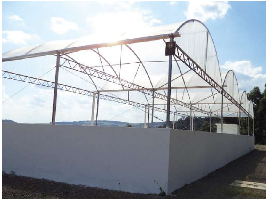
FIGURA 43. Leito de secagem de lodo proveniente de sistema semicoletivo, com cobertura de telhas metálicas (Foto: Kayo Wachholz).
