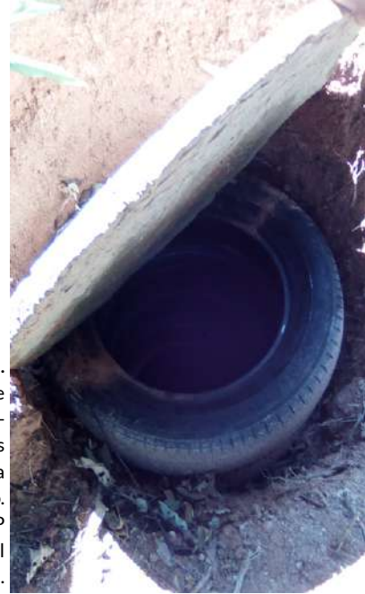
FIGURA 4. Sumidouro de material alternativo: pneus usados e tampa de concreto. Campinas-SP (Foto: Isabel Figueiredo).
