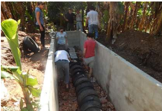
FIGURA 3. Construção da câmara de pneus e da camada de entulho (Foto: Bárbara Silva).
