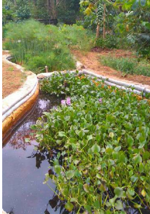
FIGURA 4. BSI semi-coletivo em início de operação. Sistema de zonas de raízes flutuantes com papiros (ao fundo) e tanque com aguapés (primeiro plano) em pousada de Ubatuba-SP (Foto e projeto: Guilherme Castagna).
