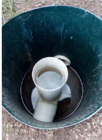
FIGURA 3. Mecanismo de controle de nível feito com tubos de PVC em sistema da EMBRAPA chamado de “jardins filtrantes” (Foto: Isabel Figueiredo).
