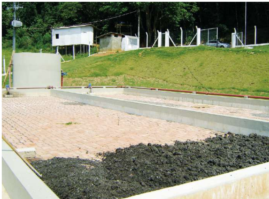
FIGURA 44A. Leito de secagem sem cobertura. Vista geral dos leitos (Foto: Kayo Wachholz).
