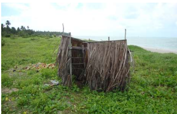
FIGURA 3. Fossa seca construída com folhas de coqueiro, a poucos metros da praia (Foto: Adriano L. Tonetti).
