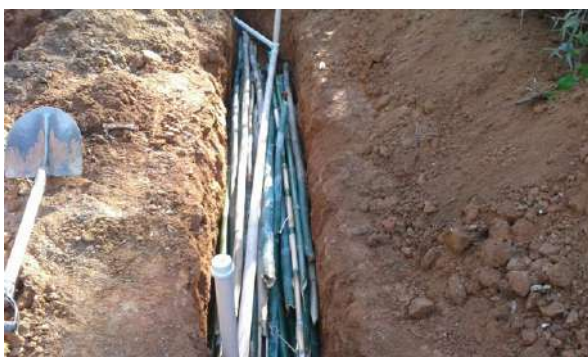
FIGURA 3. Preenchimento de uma vala de infiltração com bambu. No detalhe, a tubulação de ventilação da vala (Foto: Isabel Figueiredo).
