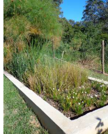
FIGURA 4. SAC unifamiliar de fluxo horizontal subsuperficial construído em alvenaria em Campinas/SP (Foto: Isabel Figueiredo).
