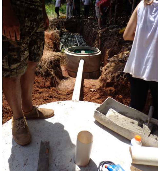
FIGURA 4. Filtro anaeróbio em construção. No primeiro plano, um tanque séptico. Depois o filtro anaeróbio e no fundo uma vala de infiltração preenchida com bambu (Foto: Isabel Figueiredo).
