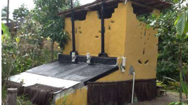
FIGURA 2. Banheiro seco construído em duplicidade em Itacaré, BA. A foto mostra a tubulação de ventilação e a câmara de compostagem (Foto: Isabel Figueiredo).
