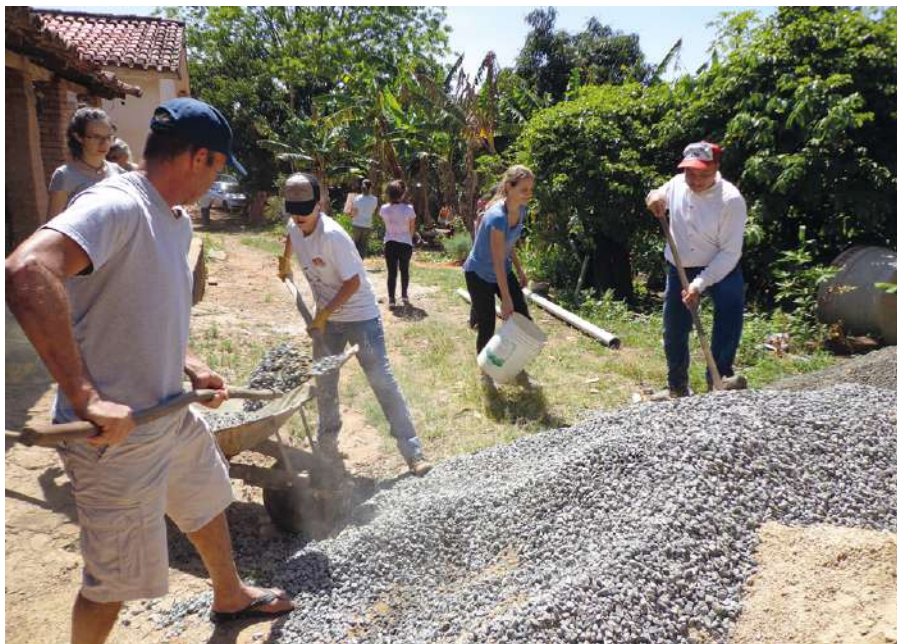
FIGURA 9A. Imagens de mutirões para a construção de sistemas de tratamento de esgoto no Projeto Saneamento Rural/Unicamp. Mutirão de construção de uma bacia de fossa verde ou evapotranspiração (Foto: Bárbara Silva).
