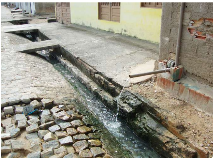
FIGURA 5. Lançamento de esgoto diretamente nas ruas de bairro urbanizado (Foto: Adriano L. Tonetti).
