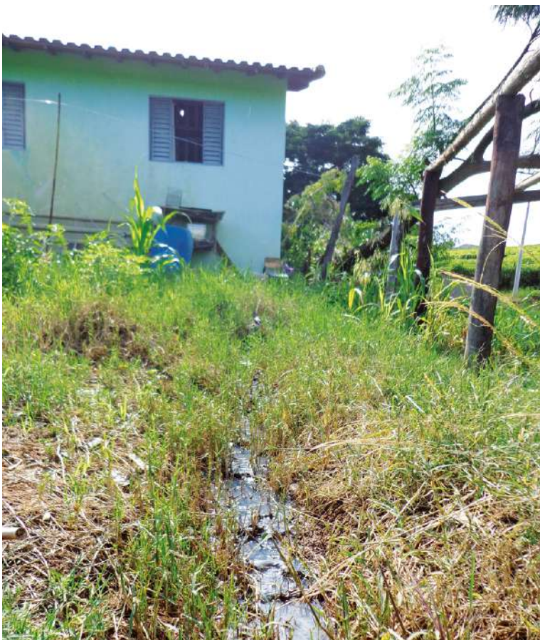
FIGURA 7. Lançamento de esgoto in natura diretamente no solo em propriedade rural (Foto: Isabel Figueiredo).
