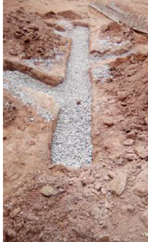
FIGURA 4. Preenchimento de uma vala de infiltração com Brita 02 (Foto: Isabel Figueiredo).
