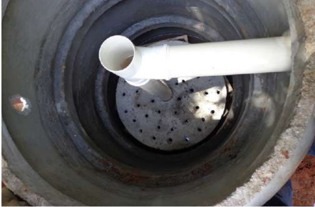
FIGURA 2. Filtro anaeróbio em construção. Detalhe do fundo falso apoiado em blocos de concreto. A imagem também mostra a tubulação de PVC 100mm por onde o esgoto entra no fundo do filtro (Foto: Adriano Tonetti).
