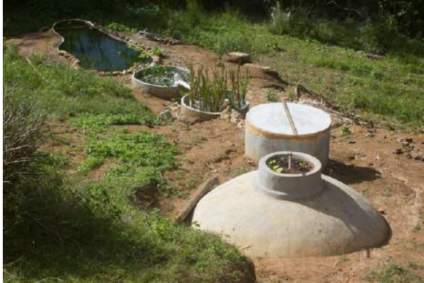
FIGURA 2. BSI que atende uma família e uma escola (Sítio Ko Yvy, Mury, RJ). O pós-tratamento do efluente do biodigestor é feito por dois filtros biológicos e um tanque de macrófitas (Projeto e foto: Tito Cals).
