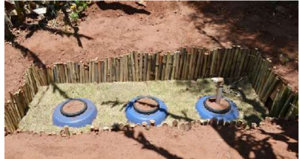
FIGURA 5. Fossa séptica econômica implantada em área rural de Pederneiras-SP (Fonte: Postigo et al., 2017).
