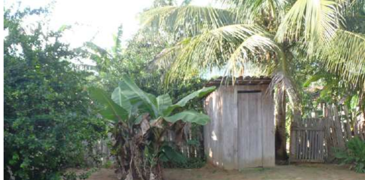
FIGURA 4. Fossa seca construída em madeira em Itupitanga-PA (Foto: Francisco Madrid).
