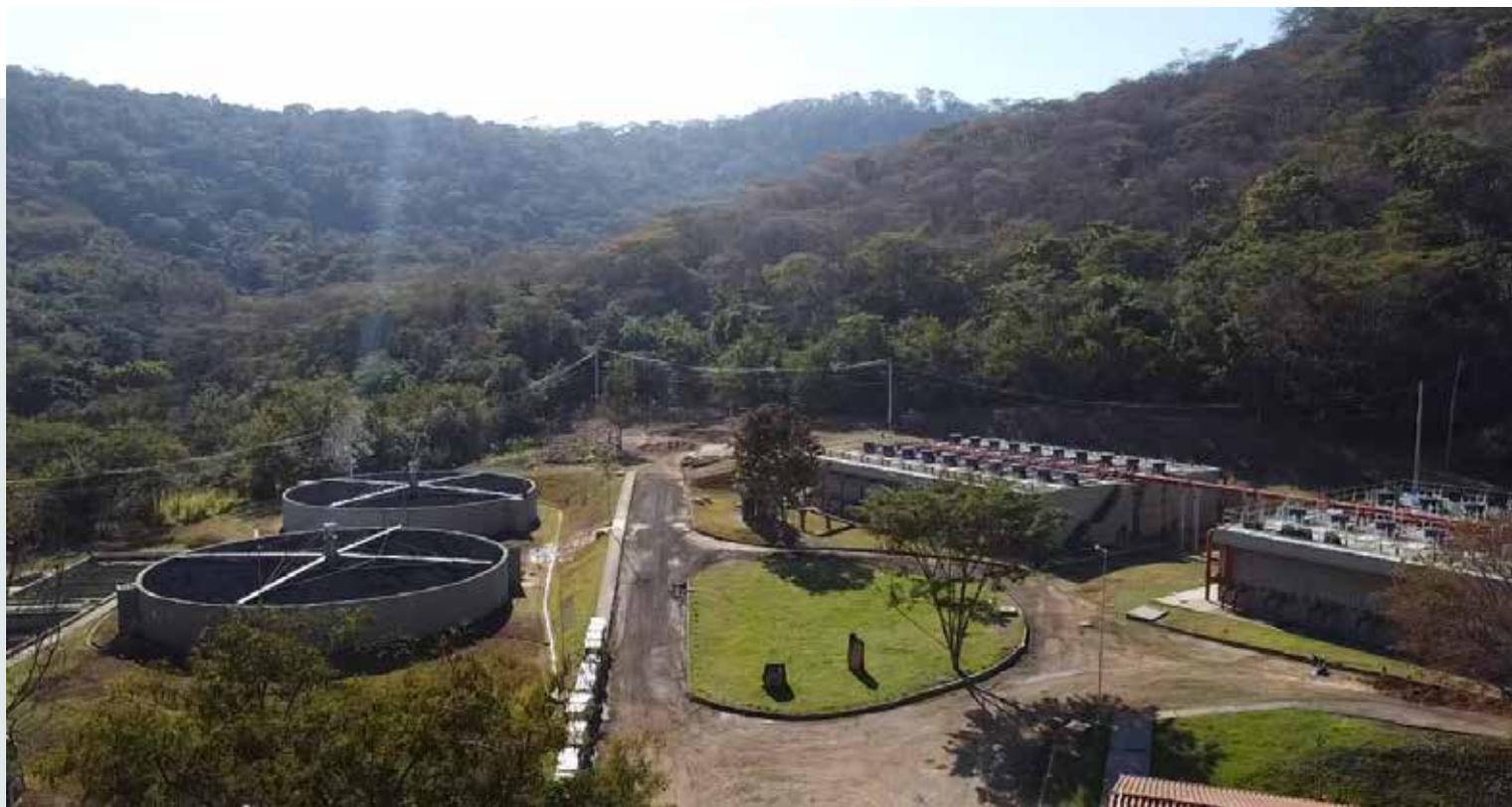
pa é a que ocupa maior dimensão na Estação e é composta por reatores anaeróbios de fluxo ascendente (UASB), filtros biológicos percoladores (FBP) e decantadores lamelares secundários. Por meio deste sistema combinado, é prevista uma eficiência aproximada de 95% na operação da ETE Itaúna.
