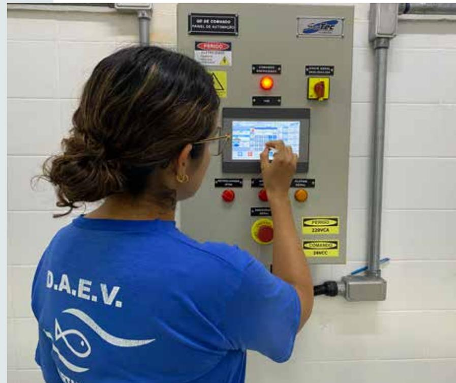
elétrico da bomba de retrolavagem (partida via soft-starter) e o fornecimento de um painel de automação com CLP e IHM para operação automática das 36
