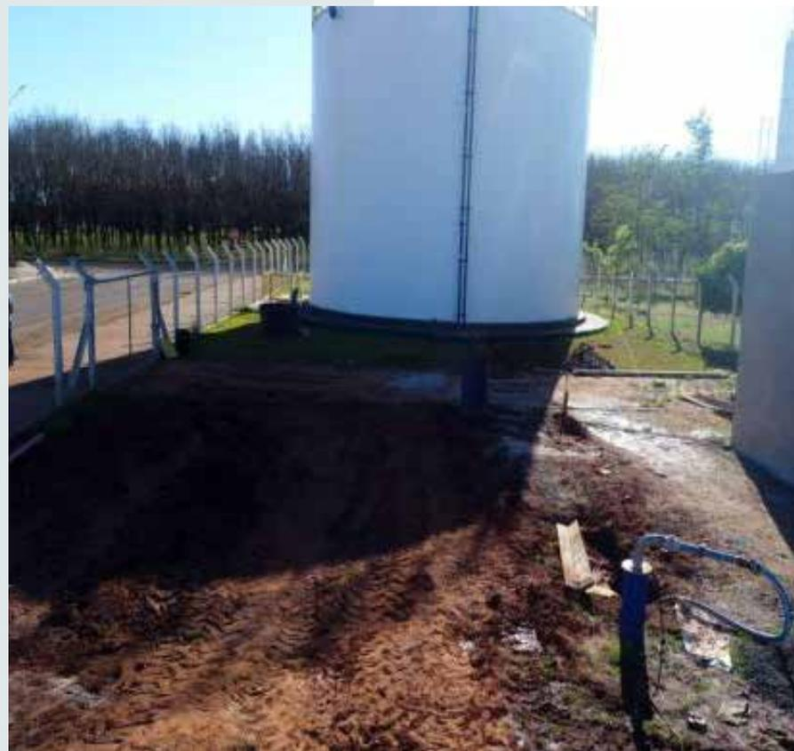
O Sistema Operacional de Abastecimento de Água do município de Chapadão do Céu, sofria com a falta de pressão de água nos principais horários do dia. Diante disso, a SANACEU implantou o sistema de pressurização tipo Booster para o melhoramento no fornecimento de água em unidades consumidoras posicionadas nas zonas com baixa influência de pressão do sistema hidráulico.
