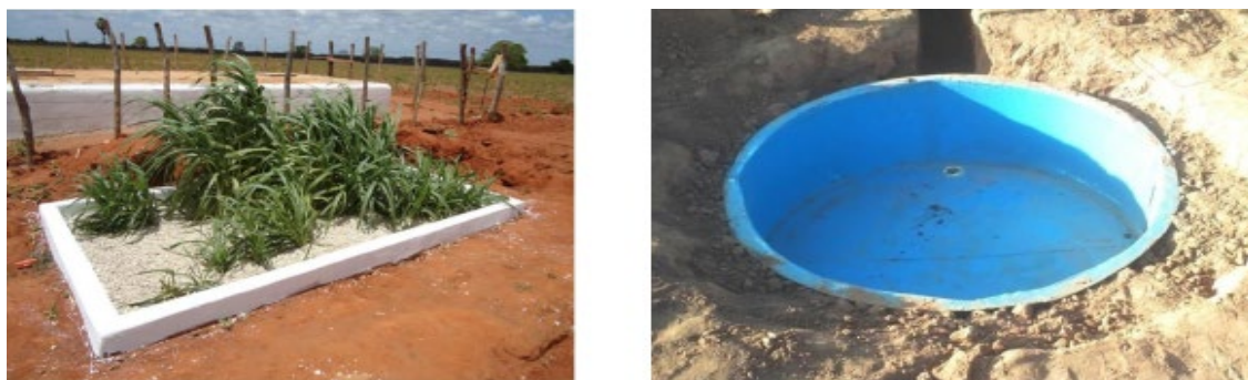
Figura 6. Sistema alagado construído e reator solar. Fonte: Reinaldo et al. (2012).
