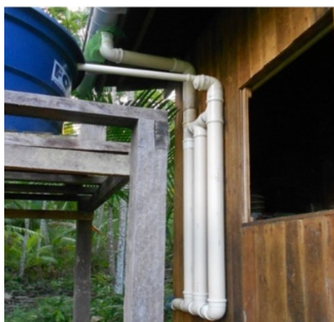
Figura 8. Sistema de captação de água de chuva. Fonte: Neu et al. (2018).
