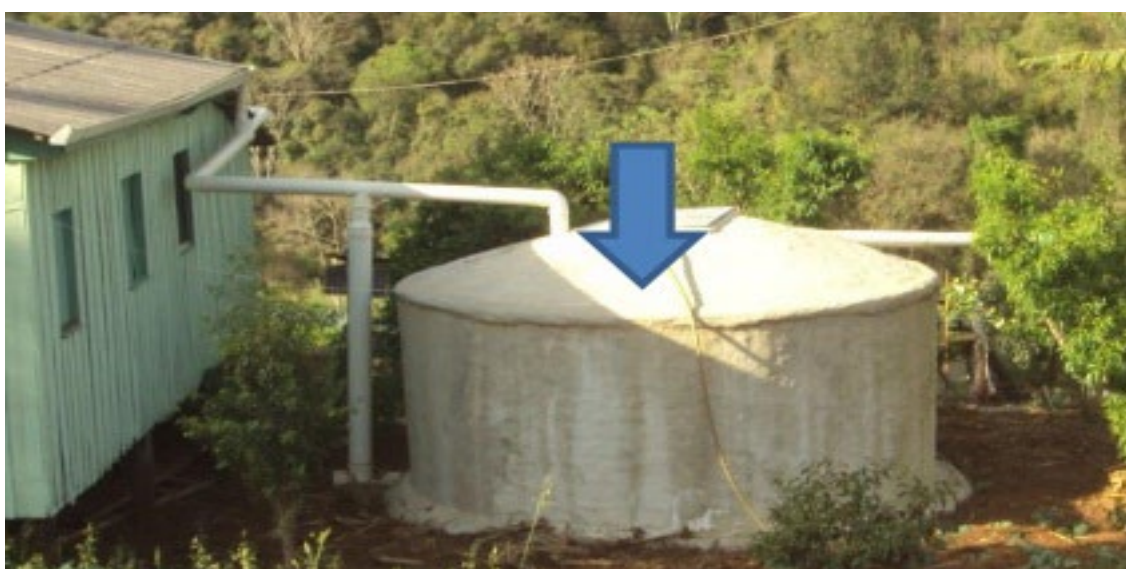
Figura 10. Sistema de ferrocimento. Fonte: Candotto et al. (2016).
